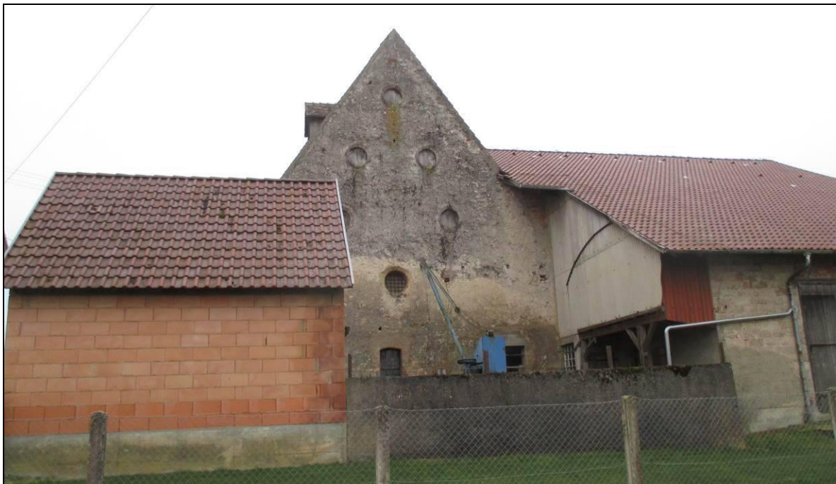
Abbildung 4 Sicht von Norden auf die Rückseite des Gebäudeensembles „Hinter der Kirche 6“.
